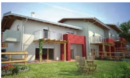
DRENA splendide ville a schiera con giardino, disposte su 3, nuova costruzione in tranquillo contesto e con ottima esposizione al sole! Ultime disponibilità. Classe A. Da Euro 330.000
