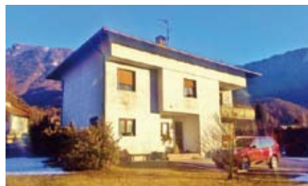
VIGO CAVEDINE casa singola con 1500 mq di giardino, con appartamento abitabile, piano seminterrato, piano terra con cantine e garage, sottotetto. Classe D. Euro 330.000
